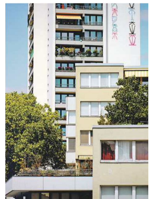
Eine Siedlung auf der Kippe: Defekte Türgriffe und verdreckte Hauseingänge
